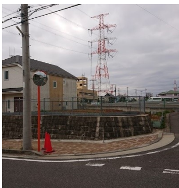
小室町カーブミラー設置
