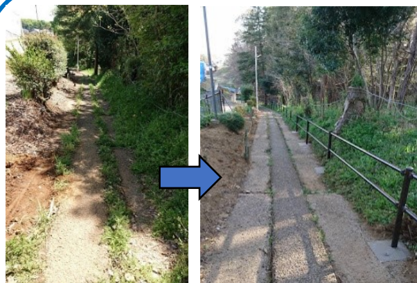
楠が山・県道鎌ヶ谷松戸線を結ぶ 通学路に手すりを設置
