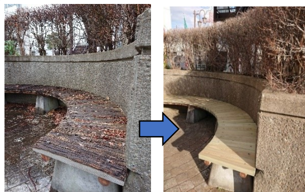
小室公民館裏のベンチを補修
