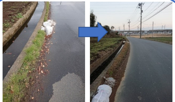
国道464号⇄鈴身町方面の市道の側溝清掃
