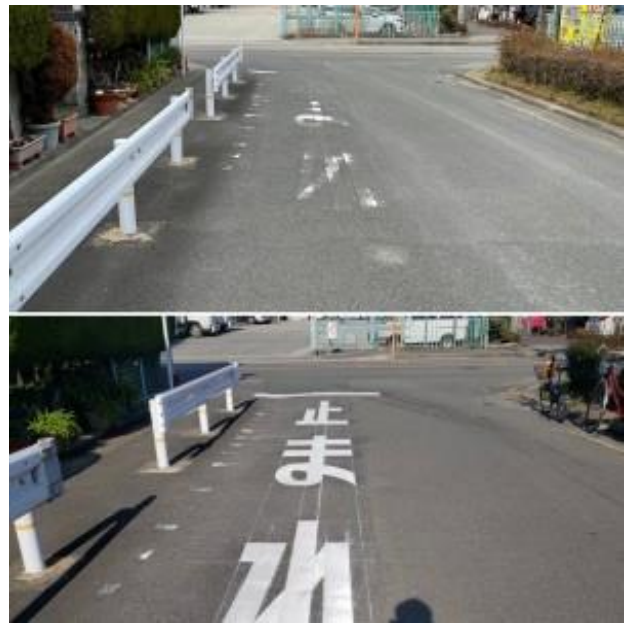
薄くなった「止まれ」標示の補修 (大塚町4丁目)
