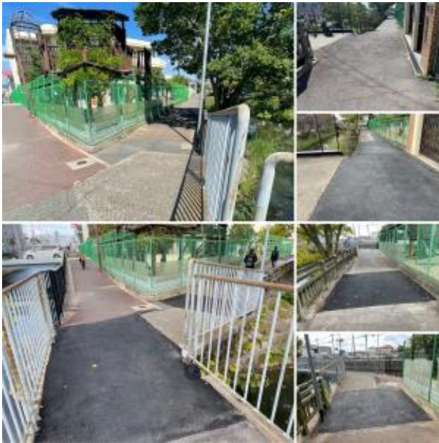
転倒防止・歩道の段差解消 (辻子3丁目)
