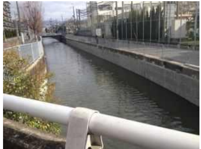
東部排水路の整備(水路底付き、壁面整備) (辻子3丁目・竹の内町) (北大樋町・南大樋町)
