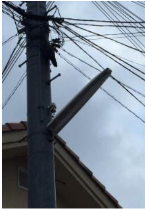
街路灯はあるが接続されていないので夜道が不安
