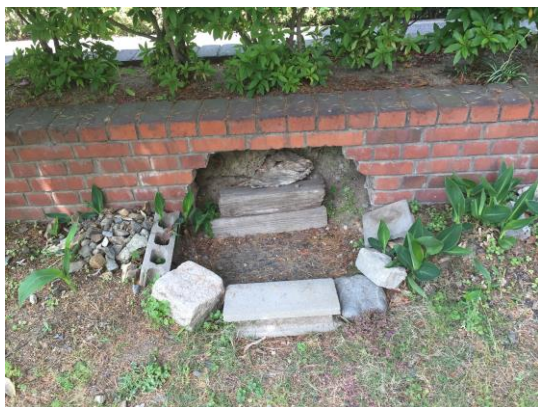
同上 マンホール
