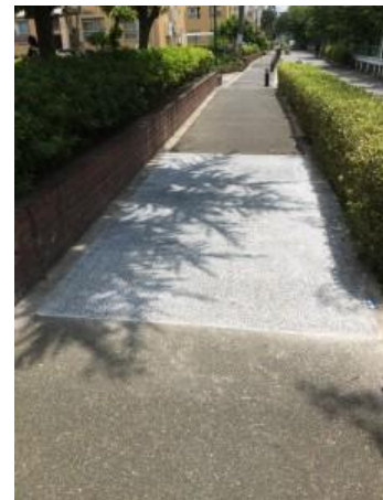
No.458 枝管補修（登町）
