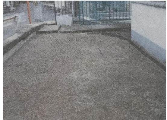
No.490 水路暗渠上の除草完了（大塚町）
