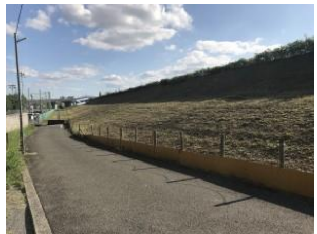
No.492 芥川河川敷のり面除草（堤町）
