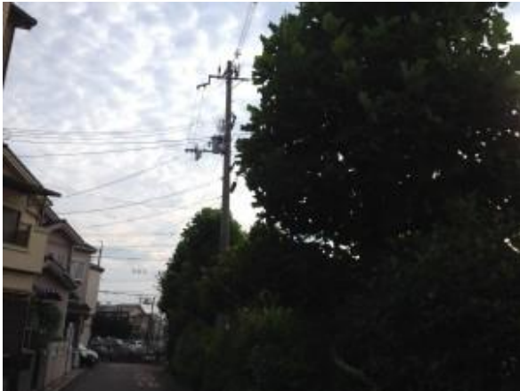
緑道の樹木が電線に・・・危険!!
