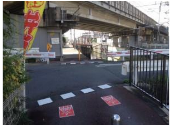
No.391 ドットラインの補修完成(辻子3丁目)
