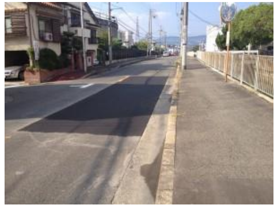
No.393 市道の局部補修（西冠3丁目）
