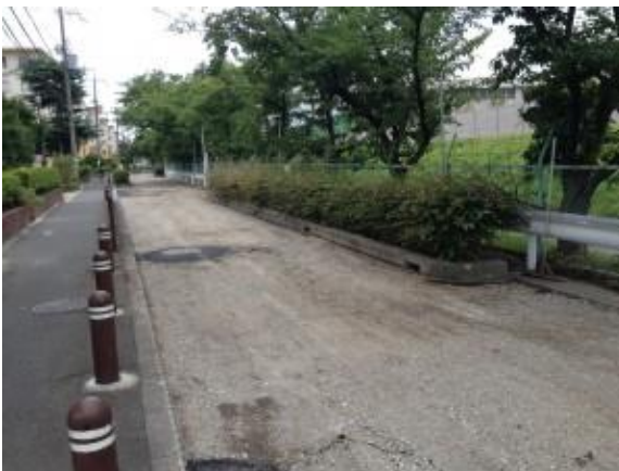
水路工事後の市道亀裂状態の補修 (工事中)
