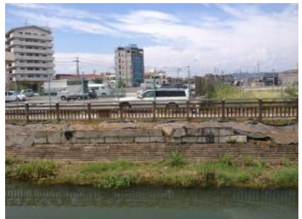
No.389 安全確認済み（辻子3丁目）
