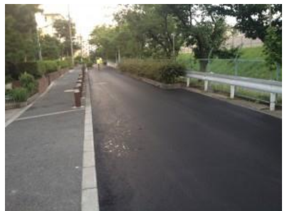
No.385 舗装完成 (登町)
