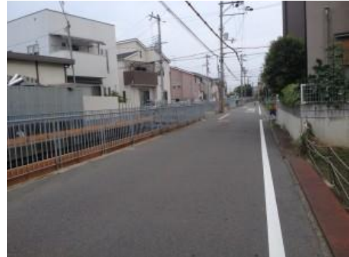
No.380 水路の改善（北大樋町）
