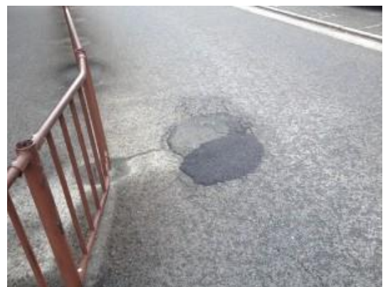
No.381 穴の補修（登町）
