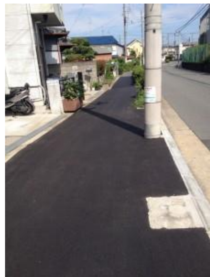
No.382 歩道の部分的舗装（大塚町1丁目）
