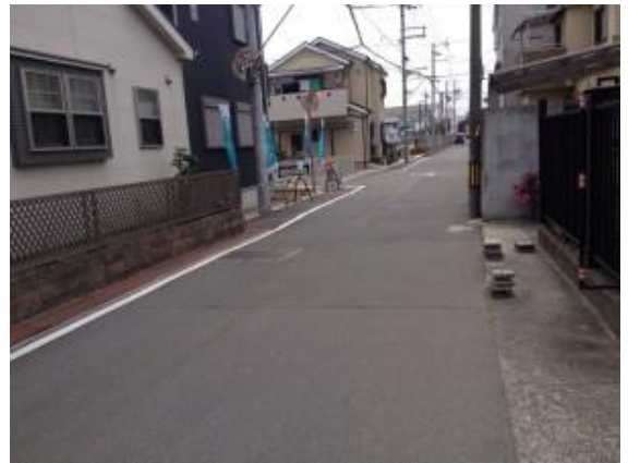
No.376 外側線・路側帯設置（深沢1丁目）
