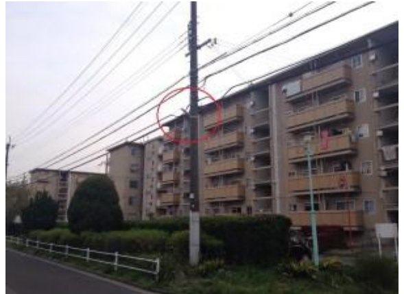
No.370 街路灯新設 (登町)
