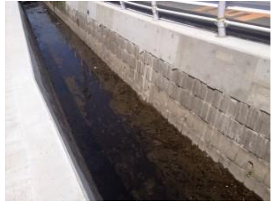
No.373 水路工事後の清掃（下田部2丁目）
