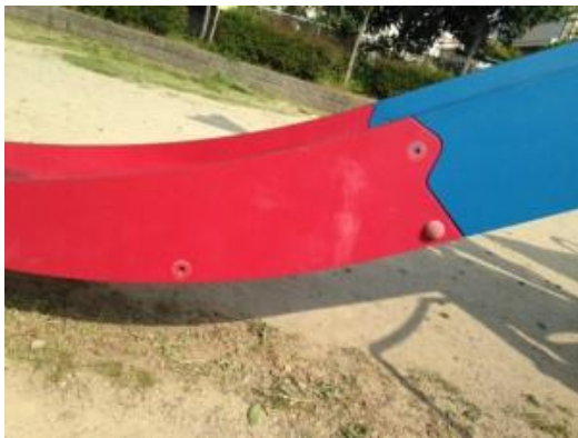
滑り台の固定ボルトが外れて危険な状態
