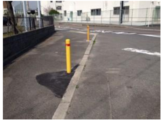
366 修理完成で安全（竹の内町）
