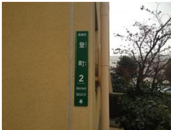
住所銘板の修理（登町）
