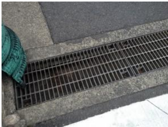
側溝内の除草・清掃（登町）
