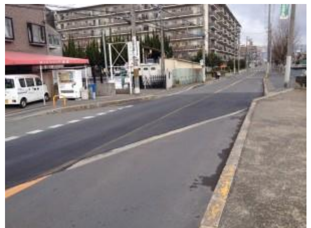
道路再舗装・凸凹解消 (南大樋町)
