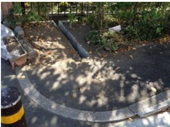
雨水対策の側溝設置
