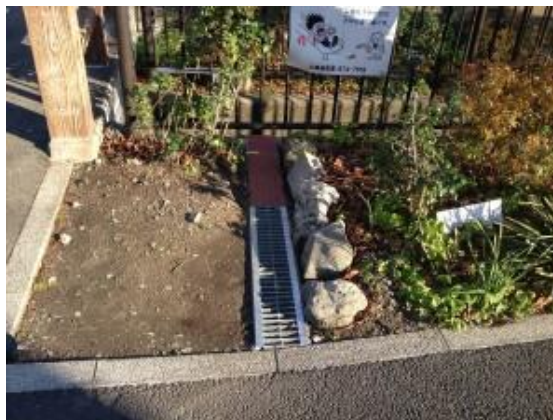
側溝にフタ設置 [半分は自治会]（西冠3丁目）
