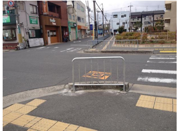
修理完了 (深沢町)
