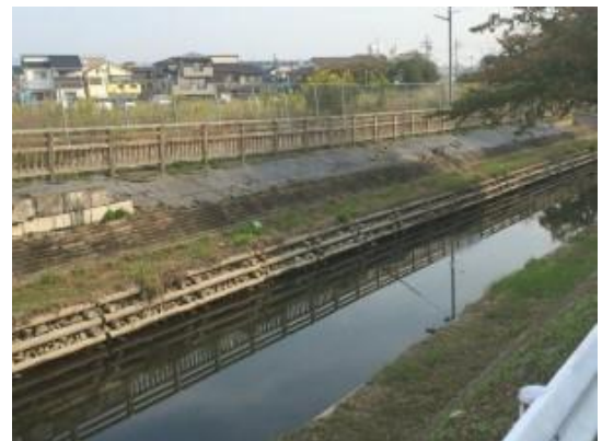
No.442 水路のり面の除草完了（竹の内町）
