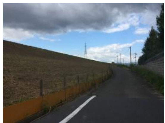
No.446 除草完了・側溝が明確に（堤町）
