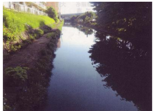
No.445 清掃完成（登町・北大樋町）
