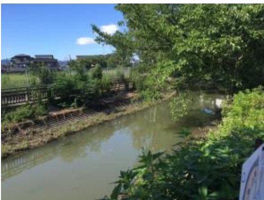
水路のり面雑草の繁茂、いつ除草!?
