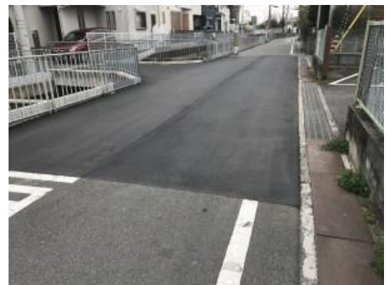
No.475 改修〈再〉工事完了（北大樋町）
