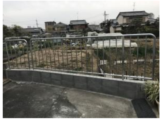
No.476 改修工事完了（深沢本町）
