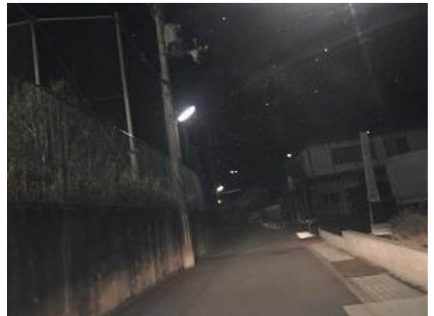
No.473 外灯修理（堤町）
