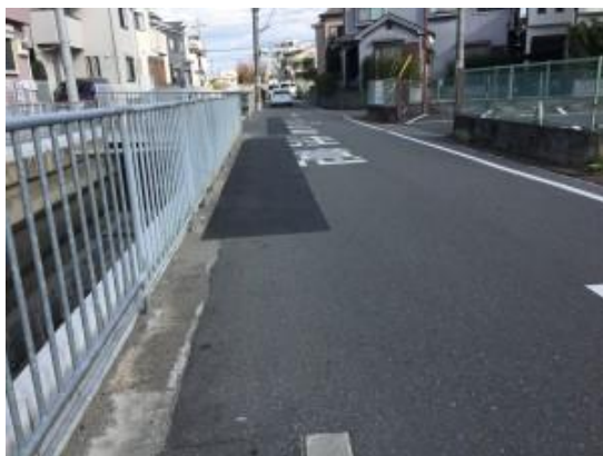
No.472 通学路の“大きな水たまり”改修工事
