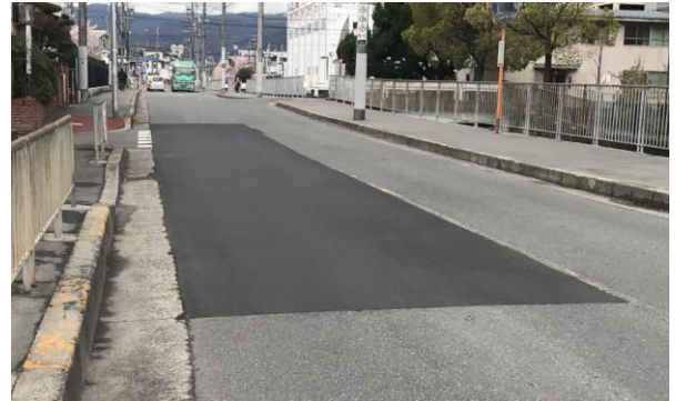
No.477 道路補修・振動解消（西大冠3丁目）
