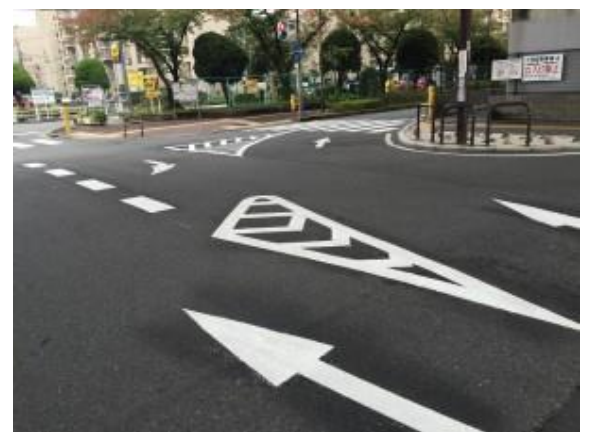
No.398 交差点整備完成 (登町)
