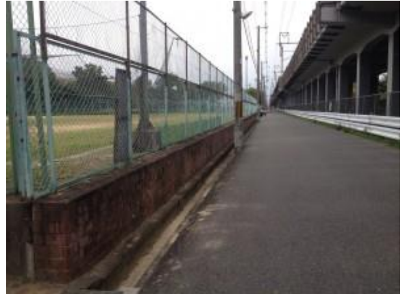
No.397 除草完了 (西大樋町)
