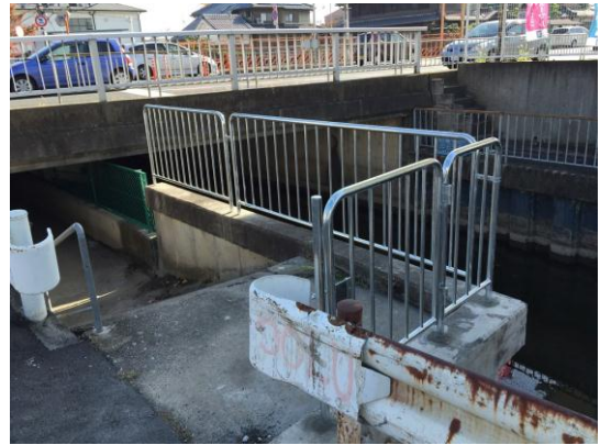
No.400 安全柵の新設（大塚町）
