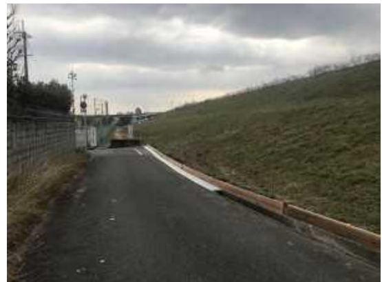
No.507 自動車の脱輪対策（堤町）
