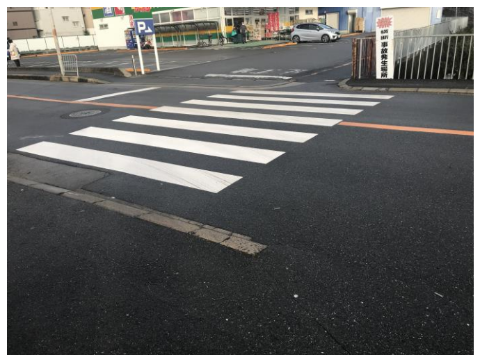
No.506 横断歩道の補修完成（下田部町 2 丁目）
