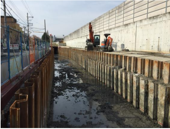
第5期 継続的な水路工事
