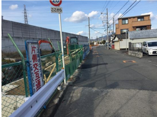
水路工事に伴う道路状況
