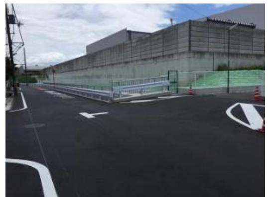
No.430 下田部水路橋の拡幅（下田部2丁目）
