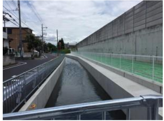
No.180 下田部水路 完結（下田部2丁目）
