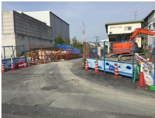
水路工事に伴う橋の状況
