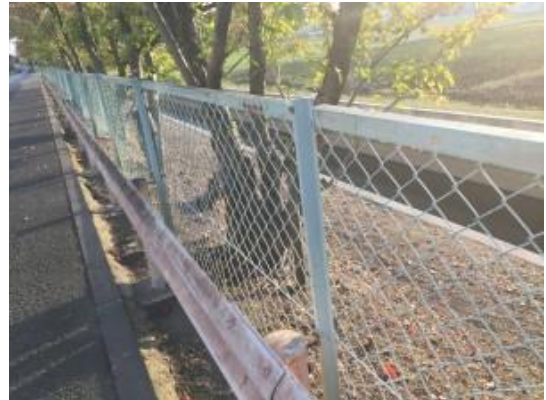
No.470 水路のり面の除草（登町）
