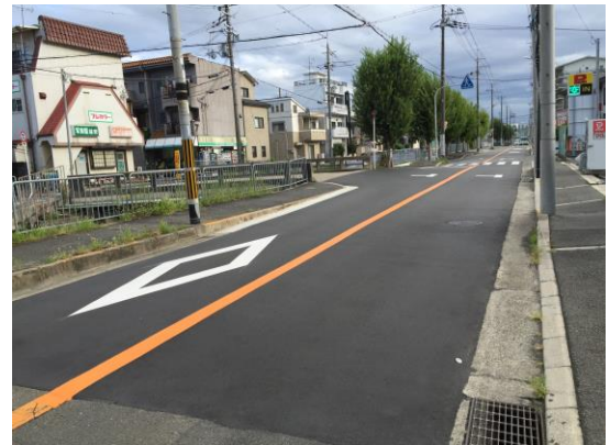
No.466 道路改修（北大樋町）
