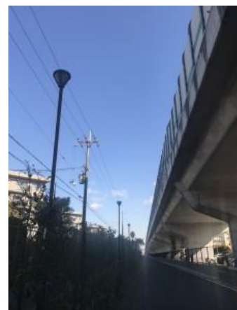
No.500 迅速な修理で点灯（登町）
