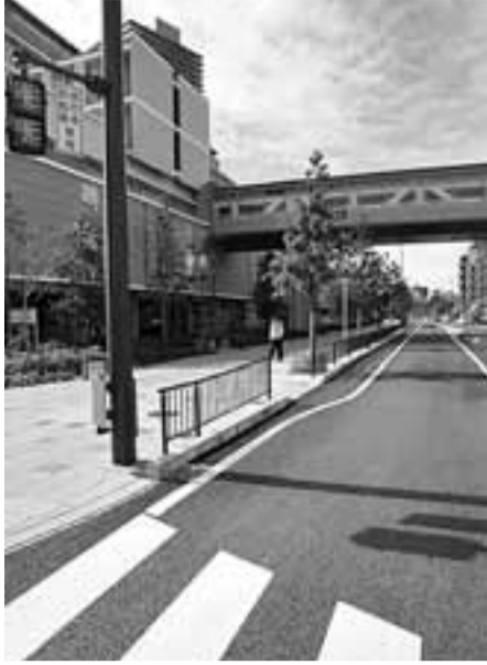
無電柱化されたJR高槻駅北東地区の古曽部天神線
