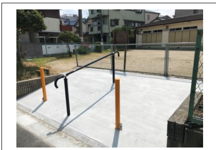
公園手すり設置（深沢本町）
