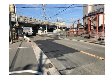
道路凹部の補修（北大樋町）
