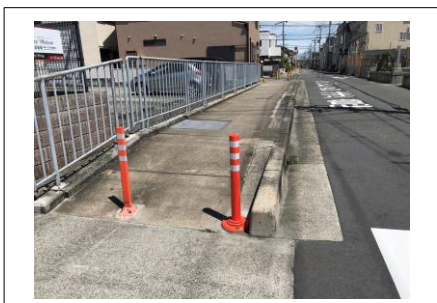
車止め等の補修（大塚町）
