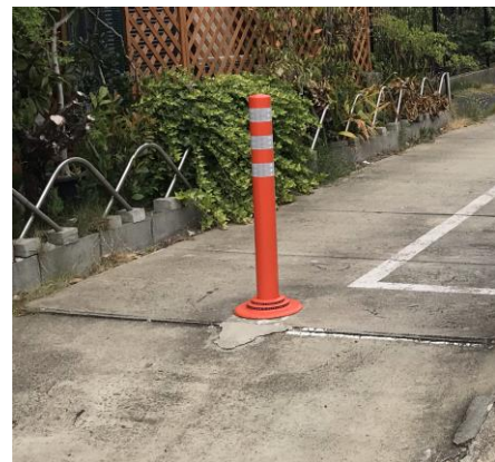
No.581 補修完了 (大塚町)
