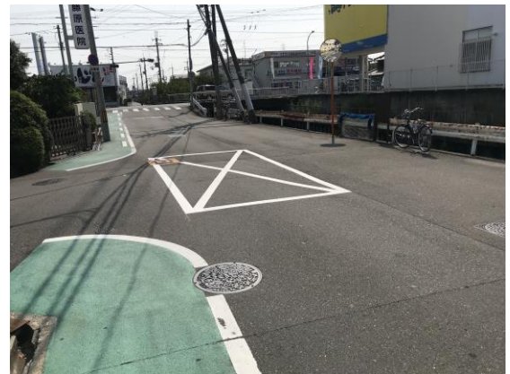
No.579-4 補修完了 (大塚町)
