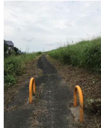
No.583 除草作業完了（大塚町）
