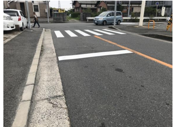
No.584 補修完了（竹の内町）
