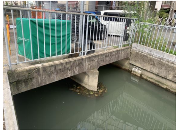
No.585 清掃完了（北大樋町）
