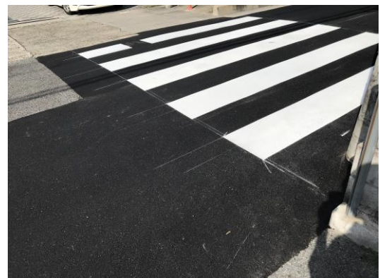
No.588-1 補修完了（大塚町）
