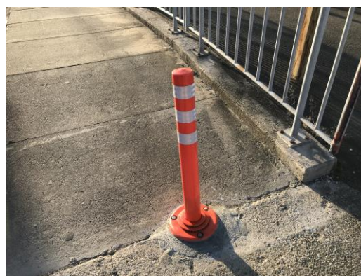
No.637 補修完了 (大塚町)
