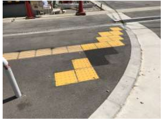
No.524 点字ブロック修理（堤町）
