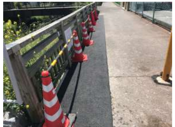
No.523 歩道補修完了（辻子3丁目）
