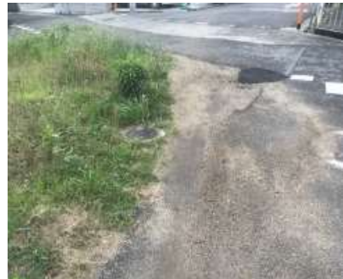
No.527 凹み部の暫定応急処理（城南町）
