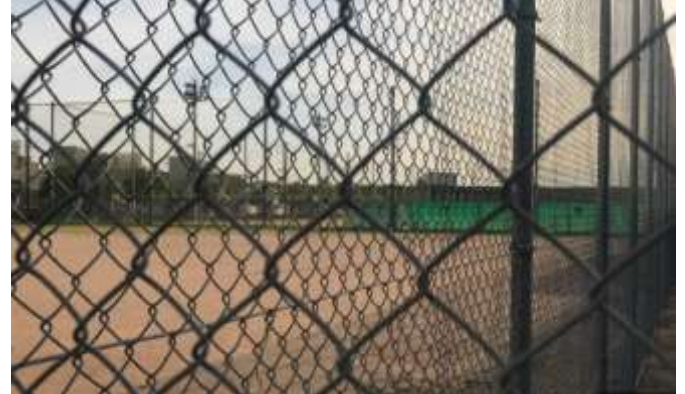
No.525 防塵カバーを設置（堤町）
