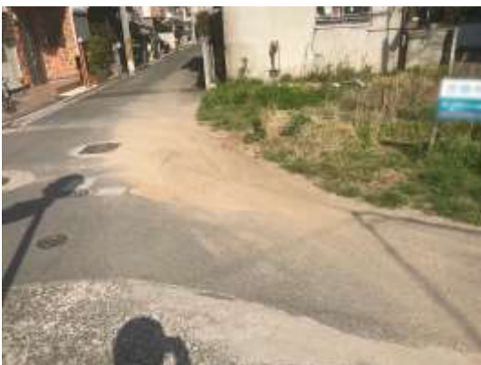
市道？ 民地？ 道路が凹み傾向でキケン
