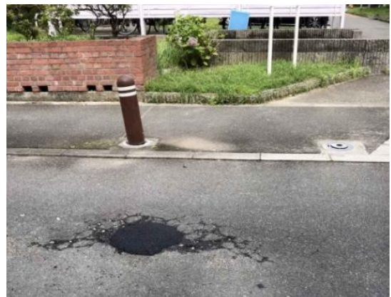
No.621 応急処置完了（登町）
