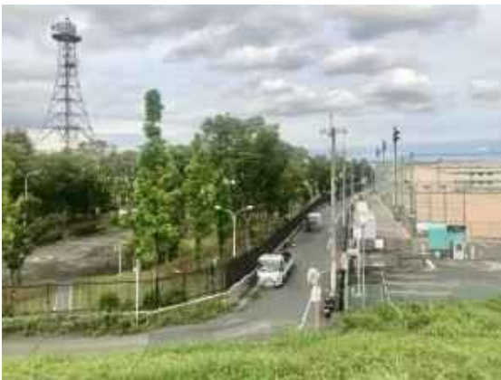
“高槻ポンプ場”の周辺仮囲い撤去
