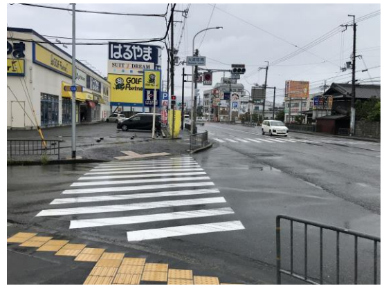
No.619 横断歩道 3 箇所の補修完了（大塚町）
