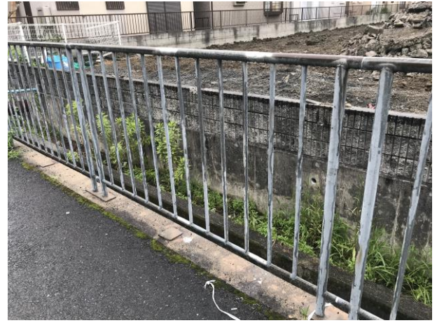
No.618 補修完了で一安心（堤町）
