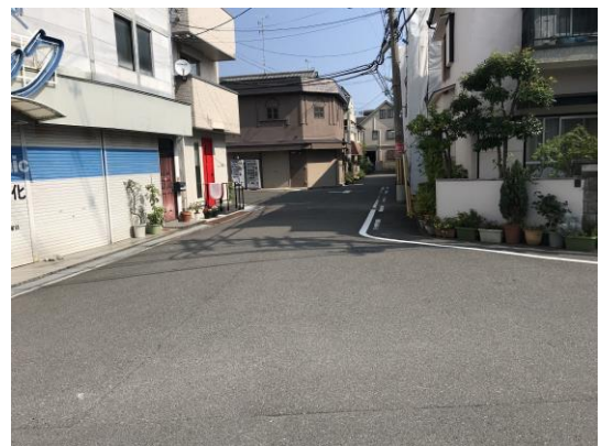
No.579-2 補修完了（大塚町）
