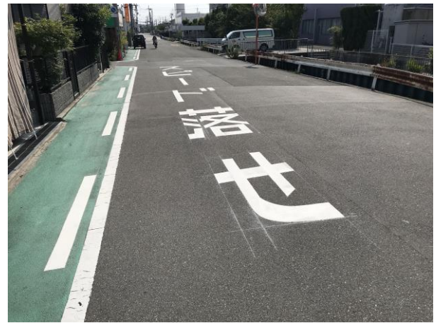
No.579-1 補修完了「スピード落せ」（大塚町）
