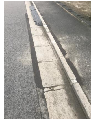
No.528 修理完了（登町）
