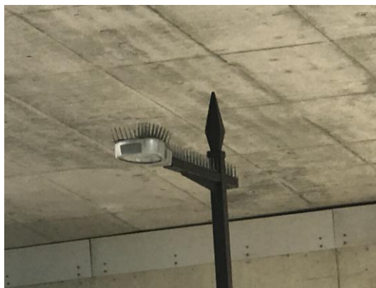
No.513 通学路の鳩糞対策完成（登町）
