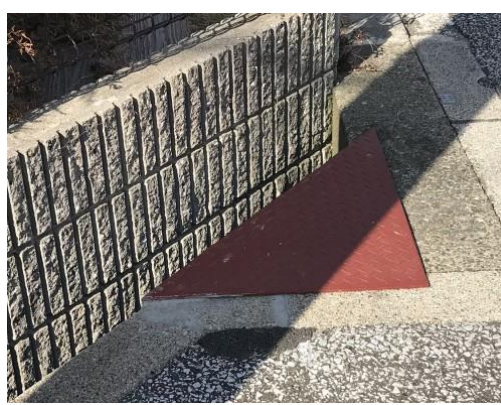
No.514 三角部分にフタを設置（上本町）
