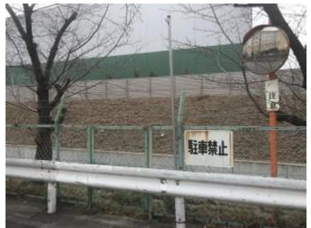
No.510 水路のり面の除草（登町）
