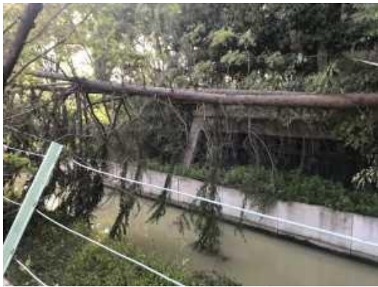
台風での倒木被害発生
