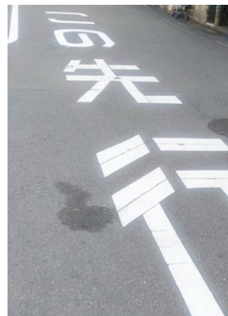
No.593 路面標示の補修（若松町）
