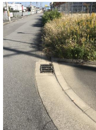
No.591 会所マスの清掃が完了（深沢町）
