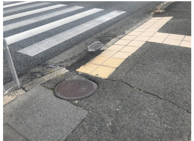
No.589 歩道の補修が完了（辻子 3 丁目）
