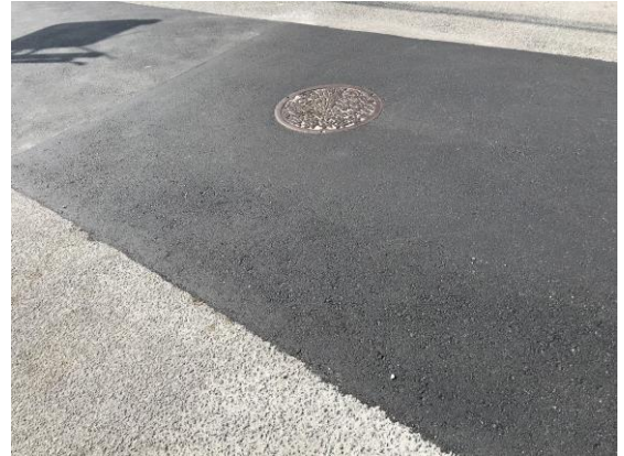
No.588-2 道路の修理が完了（大塚町）
