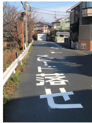
No.560 第二弾・路面標示完了（竹の内町）
