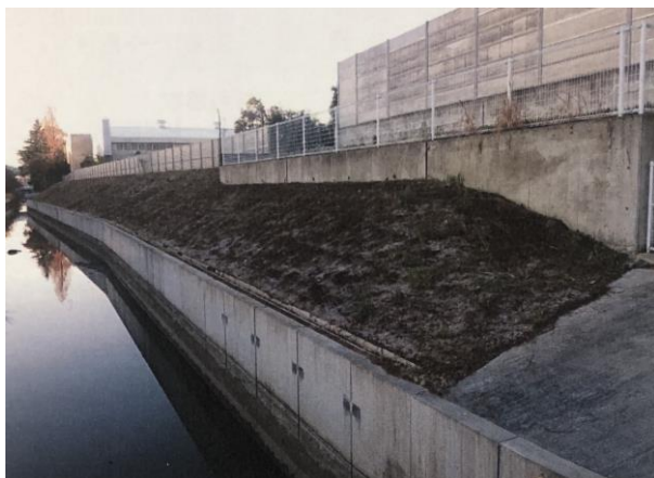
水路のり面の除草から
