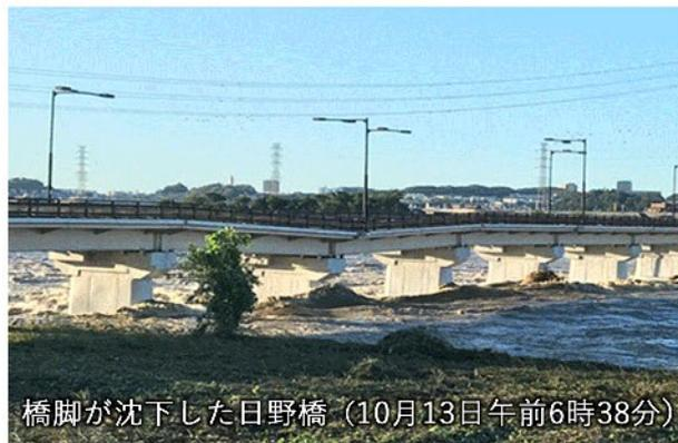
橋脚が沈下した日野橋（10月13日午前6時38分）
