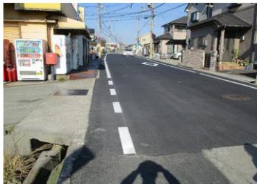
山之上地域で道路舗装の亀裂が激しく、大型車両が通行すれば振動が大きいとの声あり、町内会と連携し路面補修を実施
