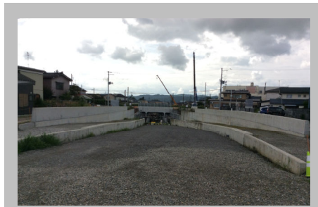
新保裏館線 信越線アンダー工区
