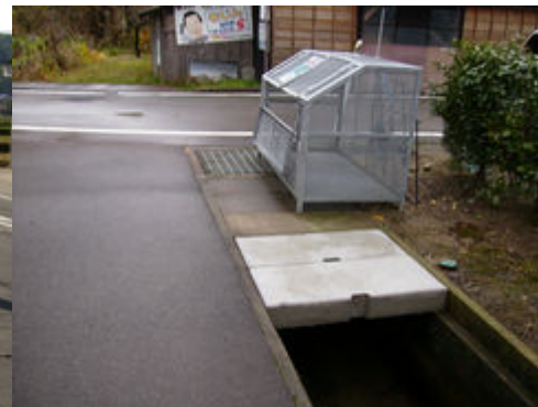
三柳地内(側溝蓋の設置)
