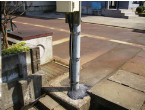
新光町地内(消雪パイプの電柱)
