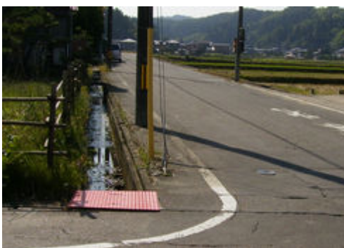
下保内地内(鉄板の蓋の設置)
