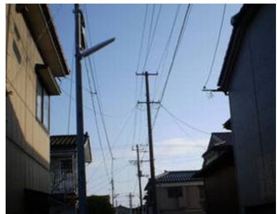
街灯が設置されました(北入蔵地内)
