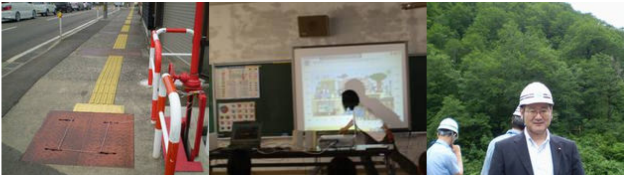
排水路の蓋の修繕（林町地内）
