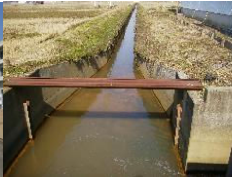
塚野目大排水路改良
