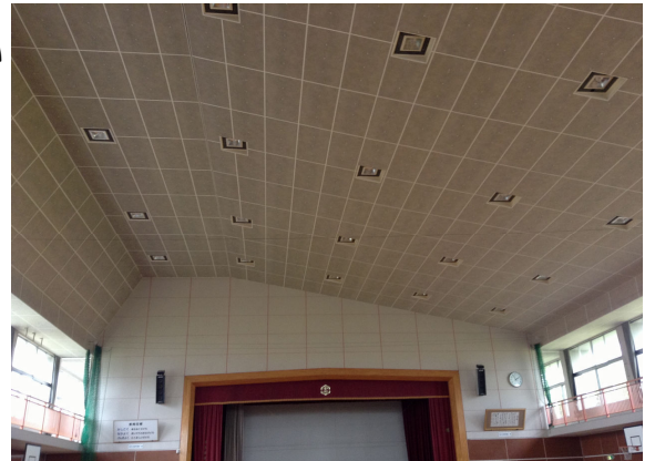
栄中央小の体育館天井
