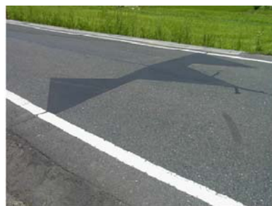
道路段差の補修 (羽栗3丁目)
