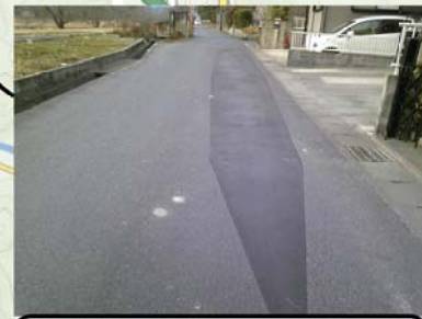
道路水溜まりの補修 (枝3丁目)
