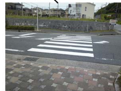
横断歩道の設置 (正休ののはな保育園前)
