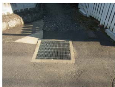
排水管 柵の設置 (里1丁目)
