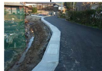
生活道路の拡幅 (桐生1丁目)
