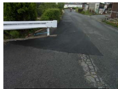
未舗装箇所の舗装 (稲津1丁目)
