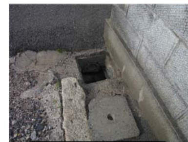
排水管の清掃 (桐生1丁目)
