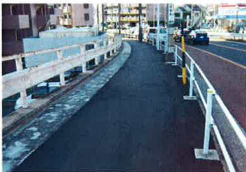
きれいに整備された歩道
