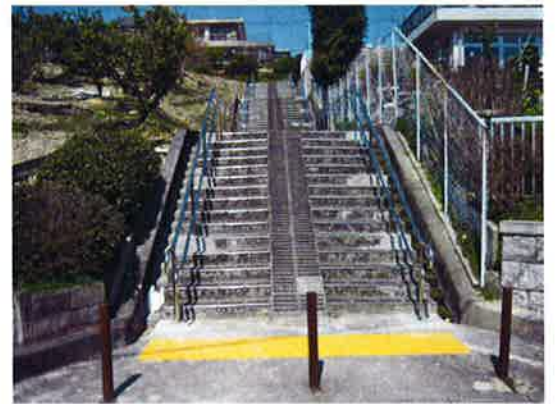
手すりが整備された階段
