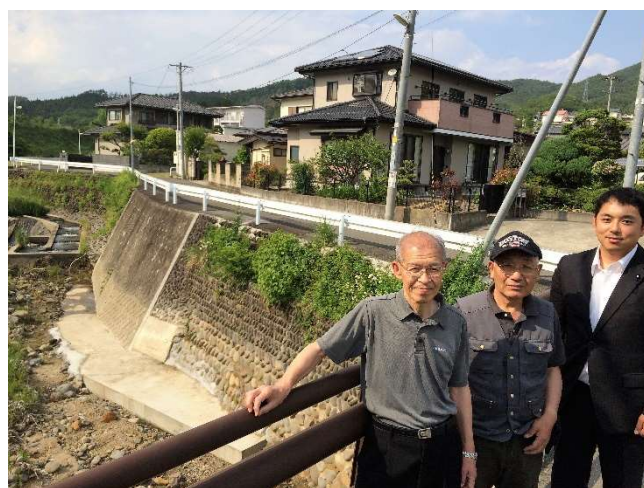
豪雨で被災した芋沢川の護岸修復（向田）
