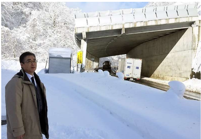
国道48号線の雪崩防止へ、スノーシェッドや雪崩防止柵を増設（作並、関山トンネル前）
