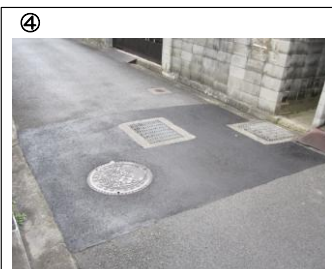
④ そして年末、土中の管路も補修され、舗装が完了しました(^^)
