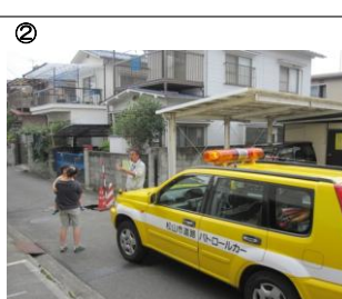
② 土曜日ですが道路パトロールカーが到着。とりあえず、鉄板で転落防止
