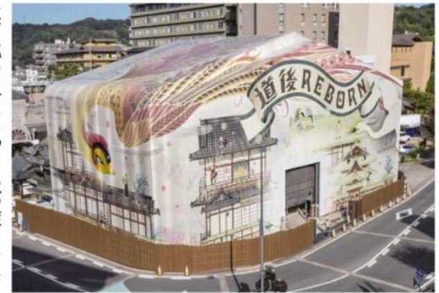
素屋根が設置された道後温泉本館
