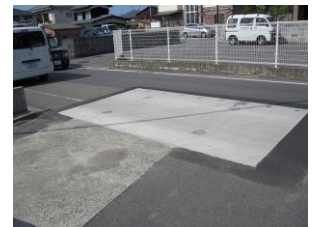
北井門の道路陥没を舗装!
