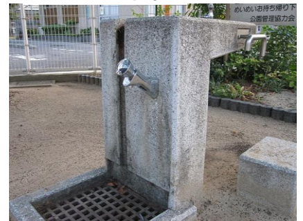
中村公園の水道蛇口を改修!
