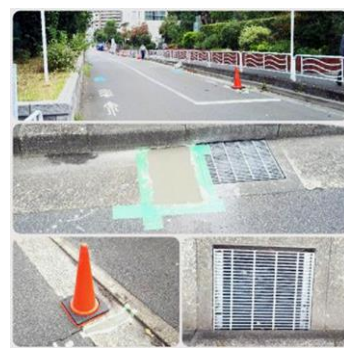
道路修繕、雨水集水柵交換(東陽)
