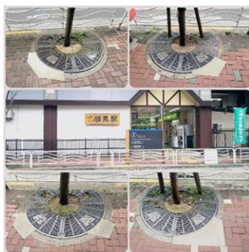
植樹柵修繕(潮見)
