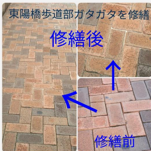
◎東陽地域 東陽橋ガタガタ解消
