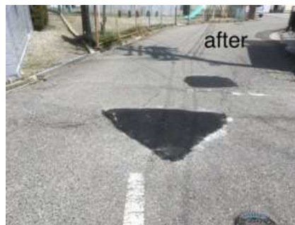
道路補修 (島立)
