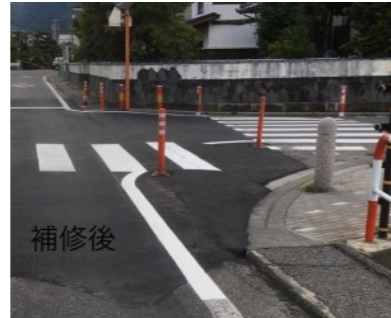
水溜まり部分の補修 (梓川)
